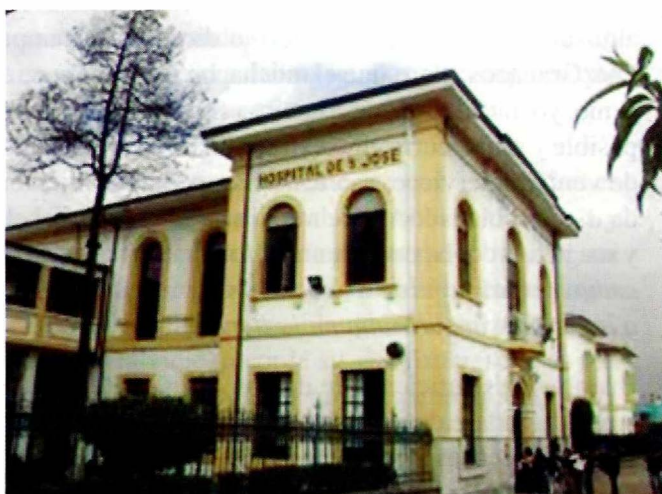
Figura 1. Hospital de San José de Bogotá DC.
